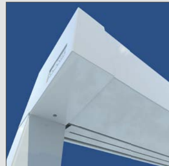
Das Ausfallprofil verschwindet beim Einfahren vollständig in der Kassette.
